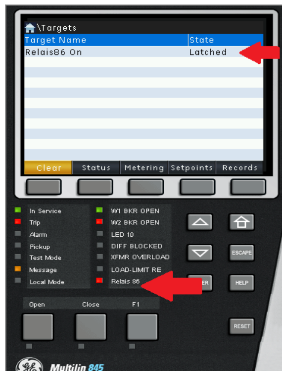
Figure 5 - Façade do relais lors du déclenchement
