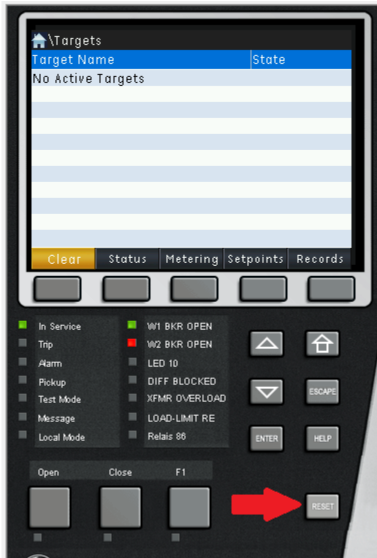
Figure 6 - Façade après la désactivation du relais 86
